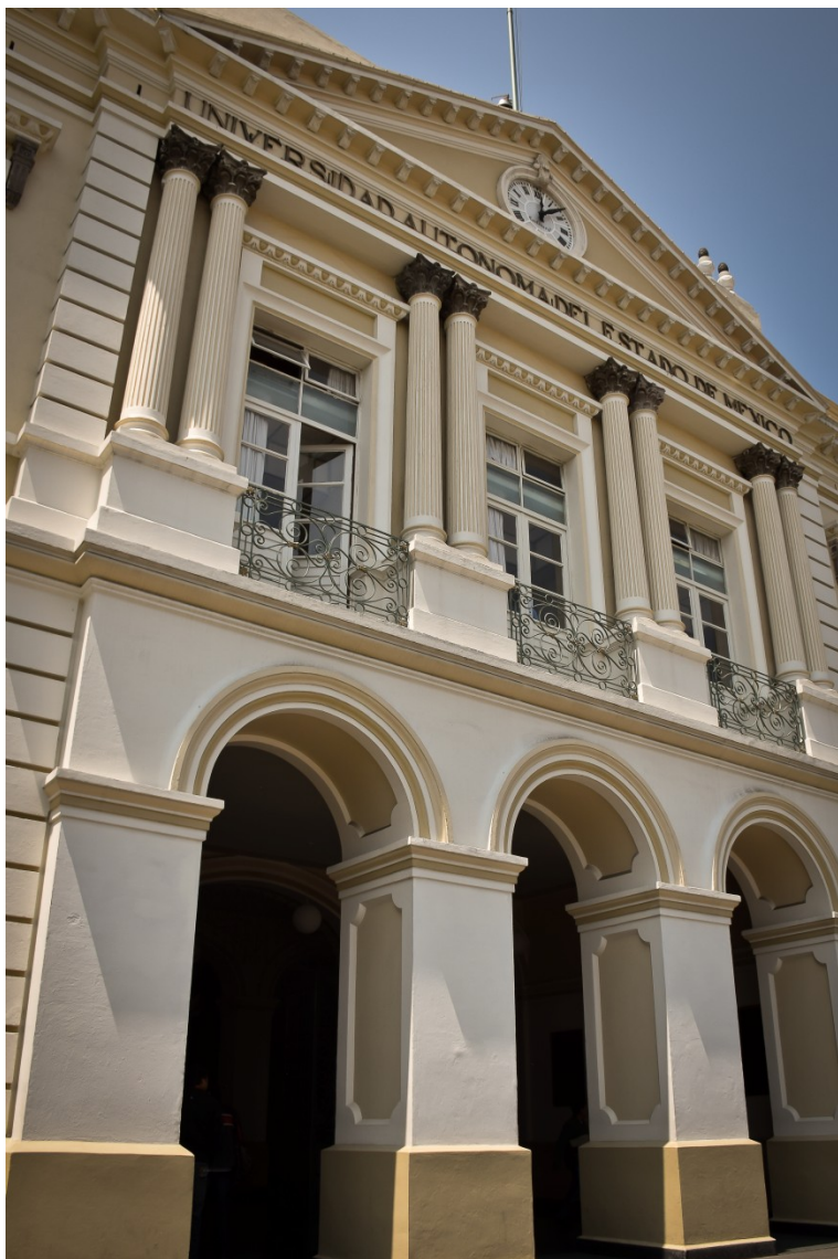
Fachada Principal del Edificio de Rectoría de la UAEM
