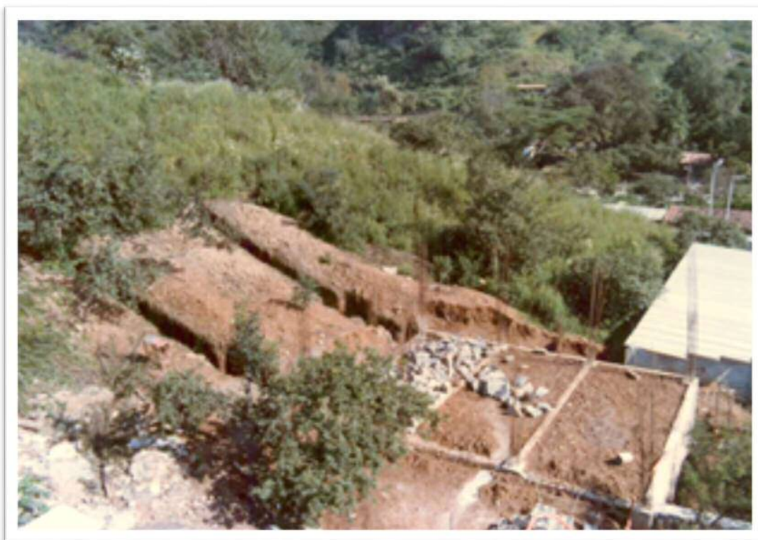
Inicio de la construcción del edificio administrativo
