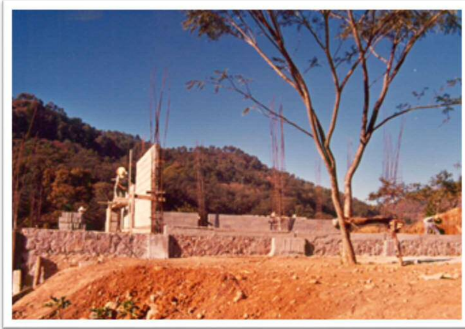
Edificio de aulas de la carrera de Ingeniero Agrónomo Zootecnista en proceso de construcción.
